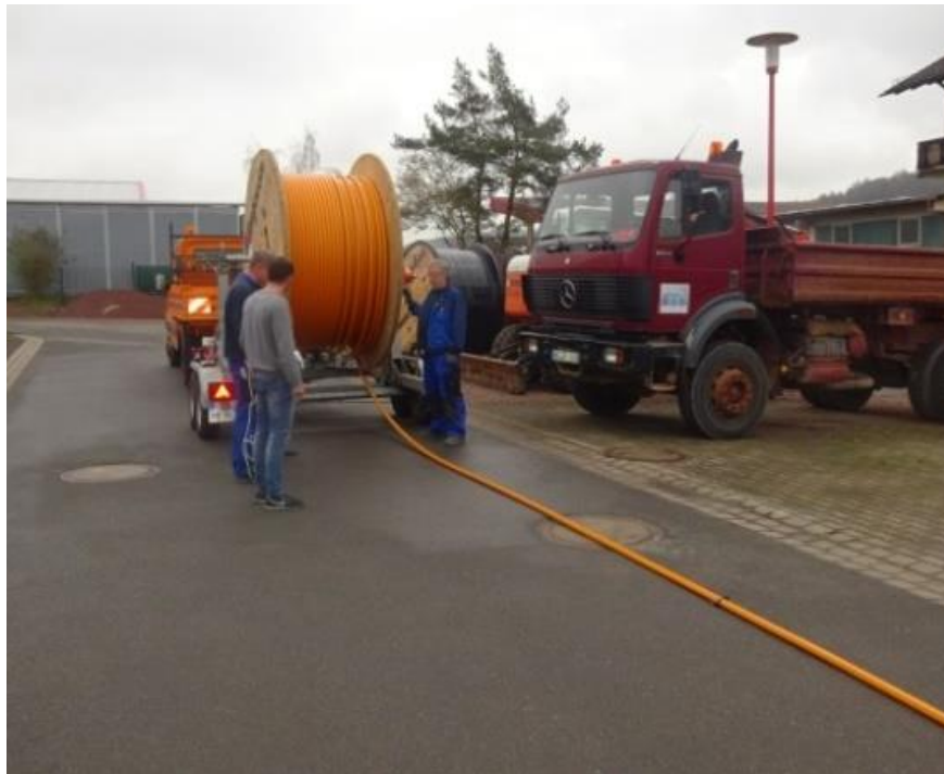
Déroutement du SRV-G tc de la bobine
