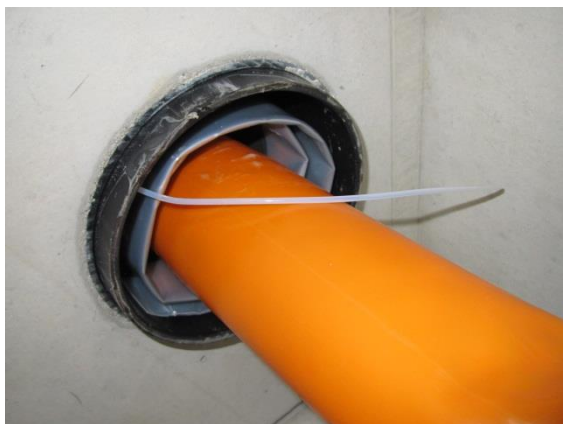
Montage commun du « ADE/TDUX de TE connectivity » dans le fourreau de conduit de câble
