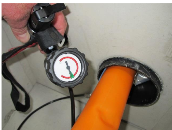
Remplissage et étanchéité du « ADE/TDUX de TE connectivity »
